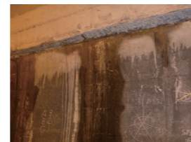
トンネルの漏水
